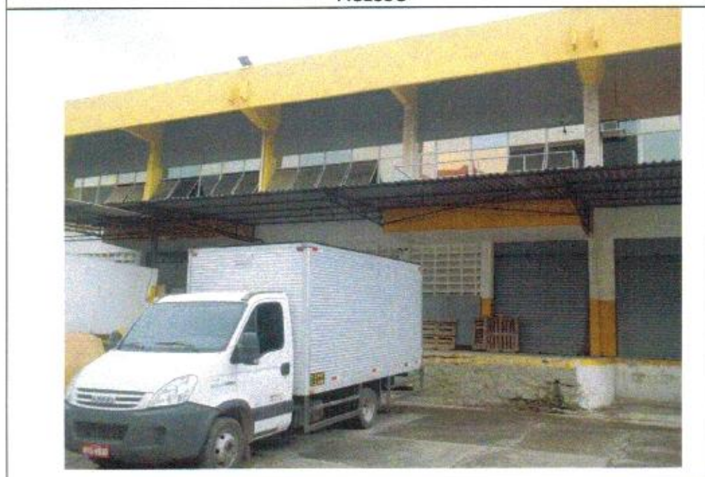
PLATAFORMA DE CARGA E DESCARGA
